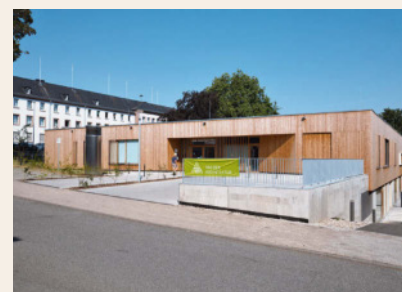
Kindertagesstätte Parkfalken in Neunkirchen; finkler.hippchen | architektur, Saarbrücken & Zerf
