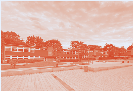
Schuster-Typ: Stadtteilschule am Brehmweg in Hamburg-Stellingen (1974), ausgeführt durch das Wohnungsbaunternehmen Neue Heimat Norddeutscher Städtebau GmbH
