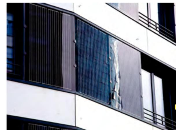
Ein Hauptertrag des Solarertrags des Aktiv-Stadthauses wird – neben dem Pultdach mit 750 Photovoltaik-Modulen – durch die Südfassade mit ihren 350 Photovoltaik-Modulen erzielt.
