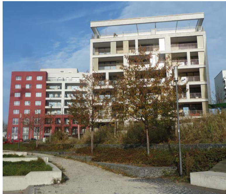
Wohnungsbau am Hafen in Offenbach. Bildrechte: HA Hessen Agentur GmbH ↑
