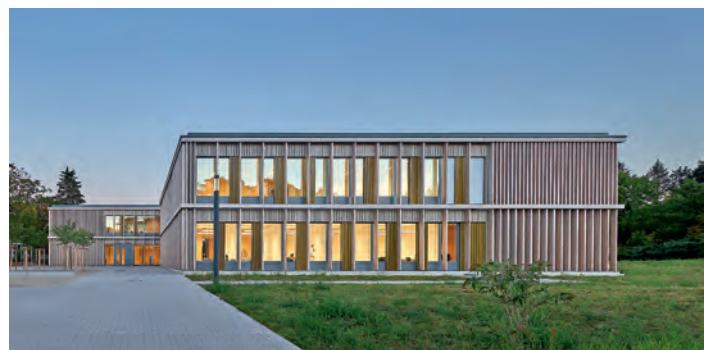
Ludwig-Schwamb-Schule und Mühltschule, Darmstadt-Eberstadt | Architekt*innen: walter huber architekten, Stuttgart | Bauherrin: Wissenschaftsstadt Darmstadt, Eigenbetrieb Immobilienmanagement Foto: Zooney Braun Fotografie
