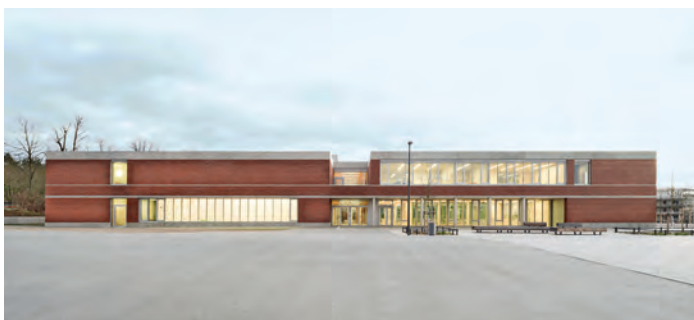
Bildungscampus Luise Büchner auf dem Konversionsgelände der Lincoln Kaserne, Darmstadt | Architekt*innen: Waechter + Waechter Architekten BDA, Darmstadt mit foundation 5+ landschaftsarchitekten bdla, Kassel | Bauherrin: Wissenschaftsstadt Darmstadt, Eigenbetrieb Immobilienmanagement Foto: Brigida González
