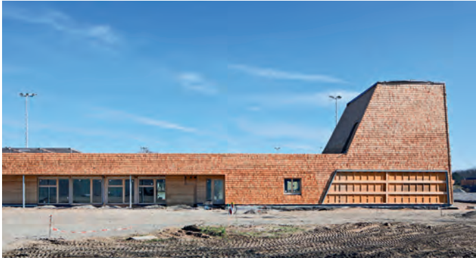
Sport- und Bildungscampus Bürstadt | Architekt*innen: prosa | Architektur + Stadtplanung BDA Quasten Rauh, Darmstadt | Bauherrin: Stadt Bürstadt, vertr. durch Bürgermeisterin Barbara Schader
