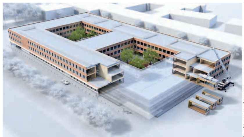
Im Frankfurter Westend entstand einer der weltweit größten Schulbauten in Holzmodulbauweise.
