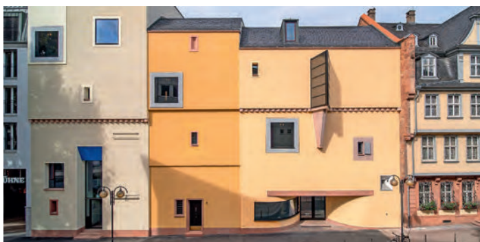
Deutsches Romantik-Museum, Frankfurt | Architekt*innen: MÄCKLERARCHITEKTEN GmbH, Frankfurt am Main | Bauherr*innen: ABG FRANKFURT HOLDING GMBH, Nutzer: FREIES DEUTSCHES HOCHSTIFT
