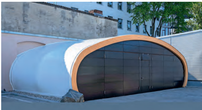
Temporäre Gärtnergerätehalle, Darmstadt | Architekt*innen: renn-architek- turDA, Darmstadt | Bauherr*innen: h_da Hochschule Darmstadt
