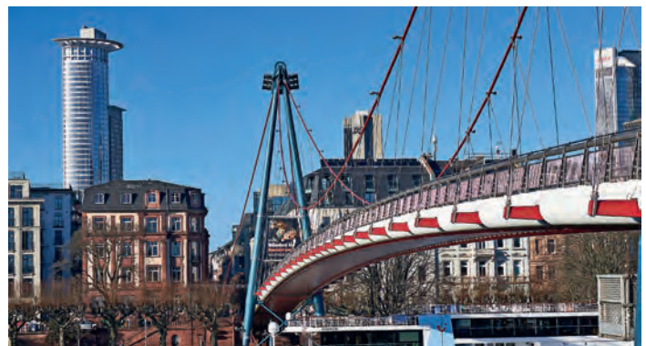
Zurück in die Zukunft, Sanierung Einzelkulturdenkmal, Frankfurt | Architekt*innen: B. A. S. Büro für Architektur + Stadt, Peter Begon, Frankfurt am Main | Bauherr*innen: privat
