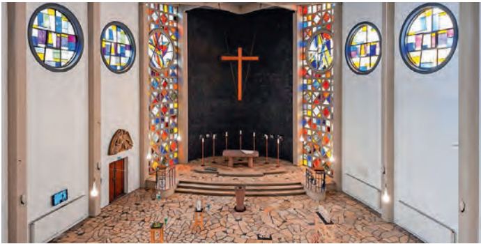
Weißfrauenkirche Innen- und Außensanierung, Frankfurt | Architekt*innen: Engelhardt Architekten, Frankfurt am Main | Bauherr*innen: Evangelischer Regionalverband Frankfurt und Offenbach
