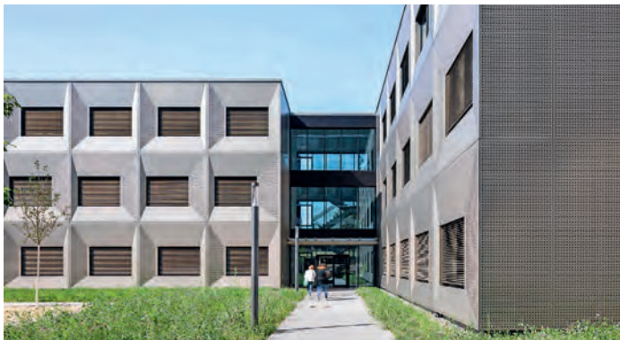
Neues Arbeiten am Kreishaus, Darmstadt | Architekt*innen: grüningerarchitekten | BDA Grüninger Kunt Muntermann PartG mbB, Darm- stadt | Bauherr*innen: Kreisausschuss des Landkreises Darmstadt-Dieburg
