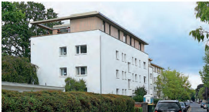
Aufstockung dreier Mehrfamilienhäuser in Eschersheim | Architekt*innen: pauly + fichter planungsgesellschaft mbH, Neu-Isenburg | Bauherr*innen: Fabio Fichter
