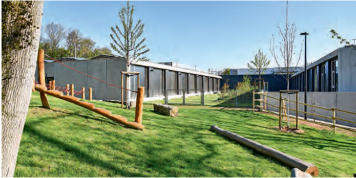
Außenanlagen Fritz-Gansberg-Schule Wiesbaden | Architekt*innen: BIERBAUM.AICHELE.landschaftsarchitekten Part GmbB | Aichele Schüller, Mainz Bauherr*innen: Wi Bau GmbH
