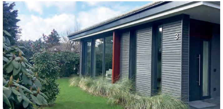
Bungalow der 1960er Jahre Ausbau und Aufstockung, Bad Homburg | Architekt*innen: JvK-ARCHITEKTEN Ruxandra-Maria Jotzu & Kornad v. Kaltenborn, Bad Homburg | Bauherr*innen: Dragan Majetic u. Martha Bojton-Majetic
