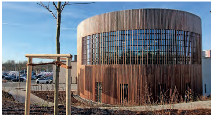
Geschäftshaus an den Gradierwerken, Bad Nauheim | Architekt*innen: Architekturbüro Dipl. Ing. Alfred Möller, Bad Nauheim | Bauherr*innen: Werner Gruppe, Fulda
