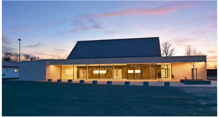
Dorfgemeinschaftshaus Neubau in Harbach | Architekt*innen: Schmees | Wagner Partnerschaftsgesellschaft mbB, Gießen | Bauherr*innen: Magistrat der Stadt Grünberg
