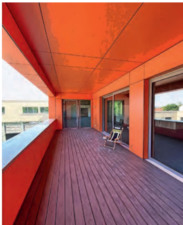
Feuerwehrgerätehaus, Rotenburg an der Fulda | Architekt*innen: STARKARCHITEKTEN, Siegen | Bauherr*innen: Magistrat der Stadt Rotenburg a.d. Fulda
