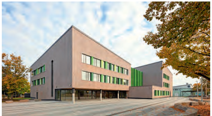
Schwarzbachschule Neubau, Nauheim | Architekt*innen: herzig | architekten ingenieure gmbh, Darmstadt | Bauherr*innen: Kreisverwaltung Groß-Gerau
