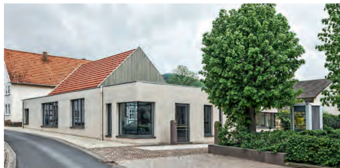
Ev. Gemeindezentrum Christophorushaus, Zierenberg | Architekt*innen: Architekturbüro Müntinga + Puy Gerhard Müntinga | Arno Puy | Jürgen Schimmelpfeng, Bad Arolsen | Bauherr*innen: Ev. Kirchengemeinde Zierenberg vertr. durch Pfarrer Friedemann Rahn
