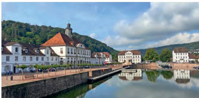
Hafenumfeld, Bad Karlshafen | Architekt*innen: GTL Michael Triebswetter Landschaftsarchitekt, Kassel und Oppermann GmbH Ingenieurbüro – Beratende Ingenieure, Vellmar | Bauherr*innen: Magistrat der Stadt Bad Karlshafen
