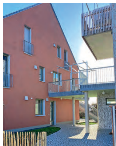
Wohnprojekt: ULIBA, Frankfurt | Architekt*innen: Klaus Korbjuhn agplus, Frankfurt am Main | Bauherr*innen: WBG Wohngesellschaft in Frankfurt am Main e. G.
