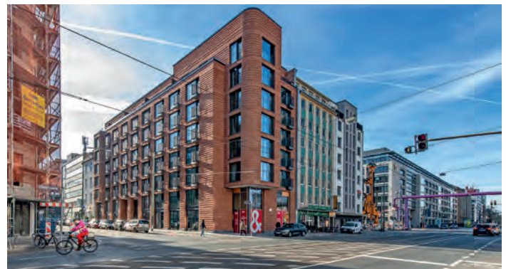
Apartmenthaus Mainzer Landstraße, Frankfurt | Architekt*innen: Stefan Forster GmbH, Frankfurt am Main | Bauherr*innen: VIVUM + CURATOR REM Foto: Lisa Farkas, Frankfurt am Main
