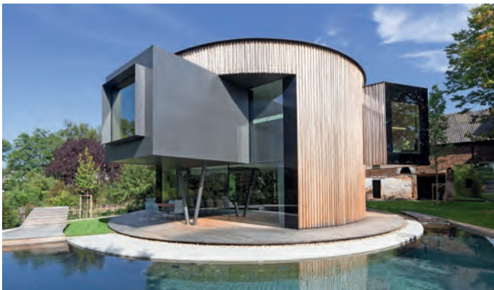
Drehhaus "Kylie", Heuchelheim | Architekt*innen: gronych + dollega architekten, Wetzlar | Bauherr*innen: privat
