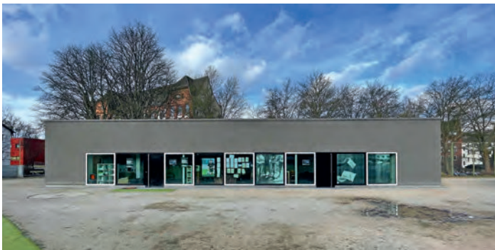
Star Care Streetbolzer-House Neubau, Kassel | Architekt*innen: Schulze Berger Architekten Stadtplaner BDA PartGmbH, Kassel | Bauherr*innen: GWG-Gemeinnützige Wohnungsbaugesellschaft der Stadt Kassel mbH
