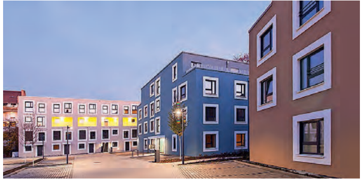
GustavsHof, Offenbach | Architekt*innen: FFM-ARCHITEKTEN. Tovar + Tovar PartGmbB, Frankfurt am Main | Bauherr*innen: Nassauische Heimstätte Wohnungs- und Entwicklungsgesellschaft mbH
