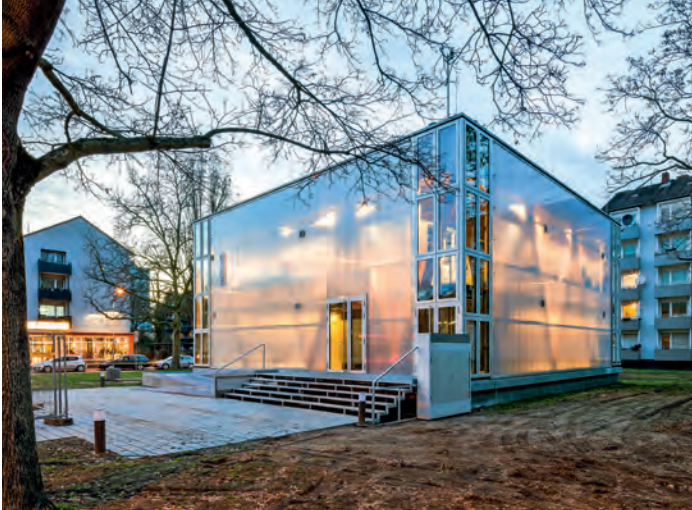
CUBITY- Plus Energy and Modular Future Student Living | Adolf-Miersch-Straße 46, 60528 Frankfurt am Main | Architekt*innen Technische Universität Darmstadt, Fachgebiet Entwerfen und Gebäudetechnologie | Bauherrin DFH Deutsche Fertighaus Holding AG, Simmern Foto: Thomas Ott, www.o2t.de
