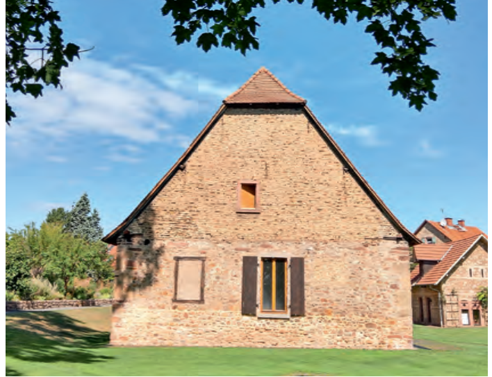
UNESCO-Weltkulturerbe Kloster Lorsch Zehntscheune Werklager | Nibelungenstraße 36, 64653 Lorsch | Architekt*innen Sichau & Walter Architekten GmbH, Fulda | Bauherrin Verwaltung der Staatlichen Schlösser und Gärten Hessen, Bad Homburg vor der Höhe
