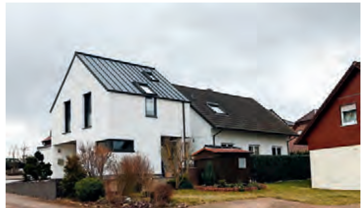
eigenständig und doch verbunden, Vellmar | Architekt*innen: Bauch Architekten | Bauherr*innen: privat
