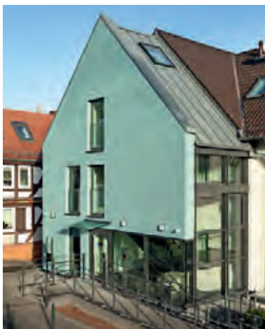
Stiftsschule Amöneburg, Sanierung Thomashauss, Amöneburg | Architekt*innen: artec architekten Gerd Kaut | Bauherr*innen: Bischöflicher Stuhl zu Fulda – Bischöfliches Generalvikariat
