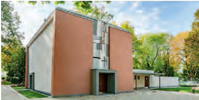
Trauerhalle Zeilsheim, Denkmalgerechte Sanierung, Frankfurt am Main | Architekt*innen: HGP Architekten Leben Kilian PartG mbB | Bauherr*innen: Stadt Frankfurt am Main - Der Magistrat - Grünflächenamt vertr. durch das Amt für Bau und Immobilien
