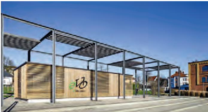
E-Bike-Station im Schilde-Park, Bad Hersfeld | Architekt*innen: ARCHITEKTURBÜRO DORBRITZ BDA | Bauherr*innen: Der Magistrat der Kreisstadt Bad Hersfeld
