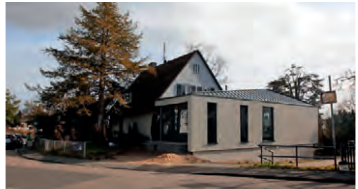
Wohnhaus Erweiterung, Kassel | Architekt*innen: punkt4 architekten Partnerschaft mbB Hanisch, Bernard und Ratka | Bauherr*innen: privat
