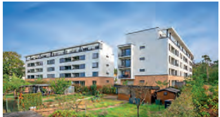
96 Wohneinheiten, Neubau mit Quartiersgarage, Darmstadt | Architekt*innen: Hoehstetter und Partner Architekten BDA PartG mbB | Bauherr*innen: bauverein AG, Darmstadt
