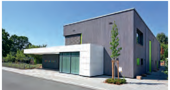
Kindertagesstätte, Neubau, Marburg-Cappel | Architekt*innen: Schmees + Wagner Architekten Partnerschaftsgesellschaft mbB | Bauherr*innen: Der Magistrat der Universitätsstadt Marburg
