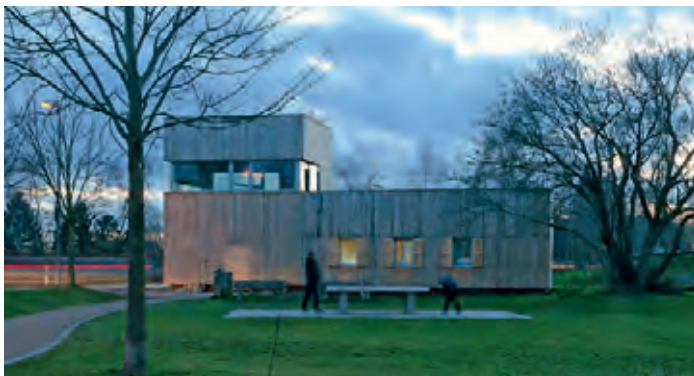
Kinder- und Jugendtreff im ehemaligen Stellwerk, Wiesbaden | Architekt*innen: A-Z Architekten Holger Zimmer | Bauherr*innen: CASA e.V. Centrum für aktivierende Stadtteilarbeit Foto: A-Z Architekten, Julius Zimmer
