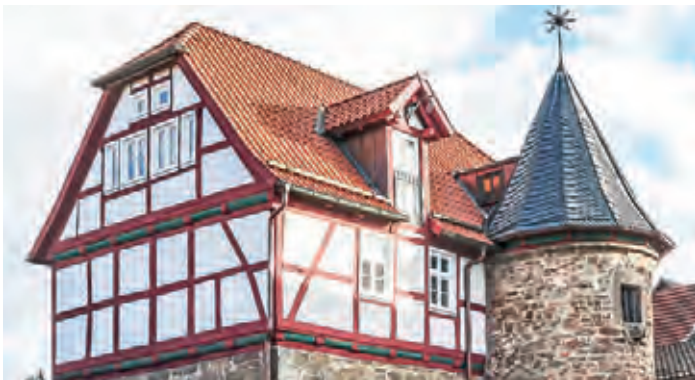
Schloss Landau, Sanierung und Umnutzung Torhaus, Bad Arolsen-Landau | Architekt*innen: Architekturbüro Müntinga & Puy | Bauherr*innen: Alexander Fitz
