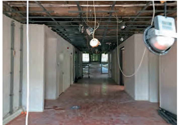
Der Bodenbelag wird im Laufe der Baumaßnahme erneuert.
