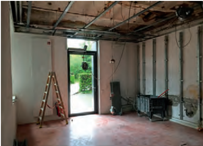
Die Decke im Gartengeschoss wurde Anfang Juni deinstalliert.
