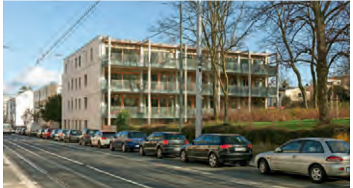
K 76, Genossenschaftsbau, Darmstadt | Architekt*innen: werk.um architekten | Botta, Lückgen, Steffen | Bauherr*innen: K76 e. G.
