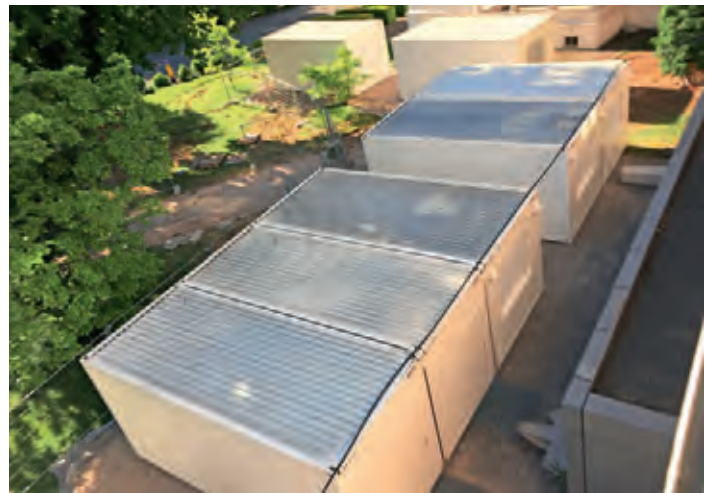
...und der Garten in ein „Container-Dorf“ verwandelt.
