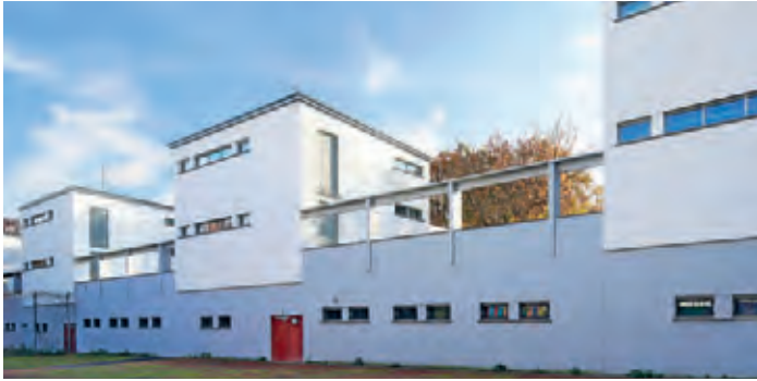
Ebbelfeldschule von 1931, Denkmalsanierung, Frankfurt-Praunheim | Architekt*innen: haber turri architekten Partnerschaftsgesellschaft mbB | Bauherr*innen: Der Magistrat der Stadt Frankfurt am Main, vertr. durch das Amt für Bau und Immobilien Foto: Eibe Sönnecken, Darmstadt
