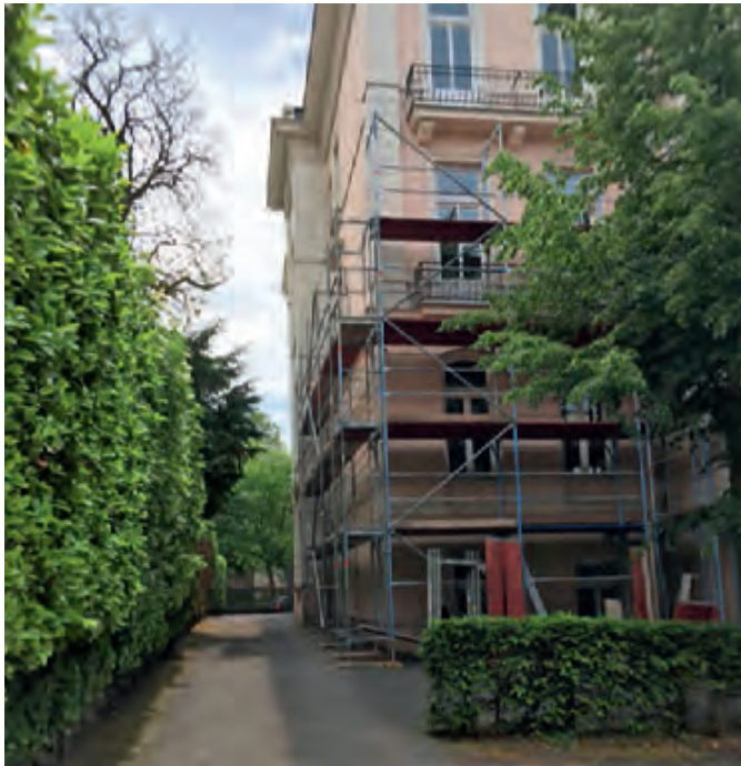
Die Gerüststellung entlang der Fassade hat zwischenzeitlich begonnen.
