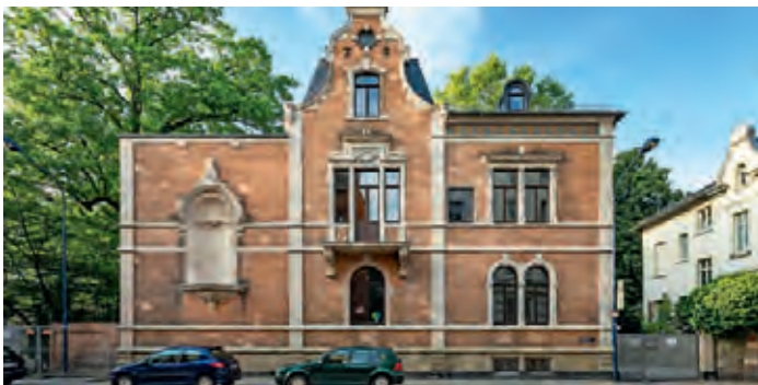
Kita Goethestraße, Sanierung denkmalgeschützter Stadtvilla, Offenbach | Architekt*innen: klaus leber architekten bda | Bauherr*innen: Magistrat der Stadt Offenbach am Main, Stadtplanung, Verkehrs- und Baumanagement
