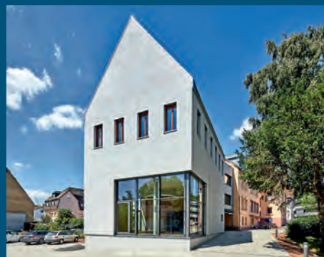
Haus der Kirche, Nidda | Architekt*innen: pätzold kremer architekten PartG mbB | Bauherr*innen: Evangelisches Dekanat Büdinger Land Foto: lumenphoto.de, Frankfurt am Main
