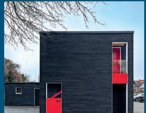
Garagenhaus Wißmar, Wettenberg-Wißmar | Architekt*innen: Gerhard Schymik. Architekt | Bauherr*innen: Gerhard Schymik Foto: Frank Schulte, Wettenberg
