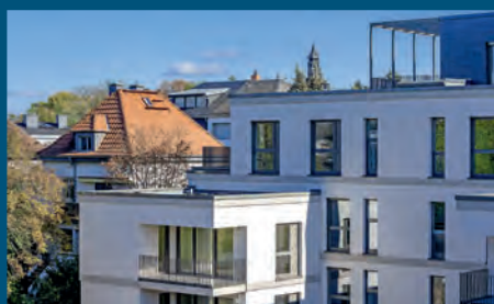
Waldfriedstraße 4 Mehrfamilienvillen am Frankfurter Stadtwald, Frankfurt am Main | Architekt*innen: wörner traxler richter planungsgesellschaft mbh / Mijaa Raummanufaktur Architekten Kucera Saronjic Scholtyssek PartG mbB | Bauherr*innen: privater Bauherr
