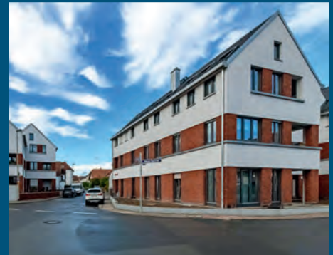
Nachverdichtung in Kalbach, Frankfurt am Main | Architekt*innen: Stefan Forster GmbH | Bauherr*innen: privater Bauherr Foto: Lisa Farkas, Frankfurt am Main
