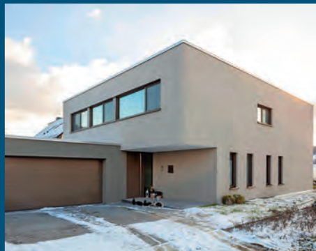
Einfamilienhaus M1, Neu-Anspach | Architekt*innen: Architekten Müller & Kölsch Partnerschaftsgesellschaft | Bauherr*innen: privater Bauherr
