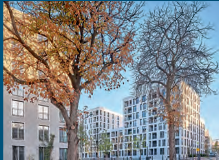
Quartier am Henninger Turm, Frankfurt am Main | Architekt*innen: Baufrösche Architekten und Stadtplaner GmbH | Bauherr*innen: Quartier am Henninger Turm GmbH & Co. KG Foto: Norbert Miguletz Fotografie Frankfurt
