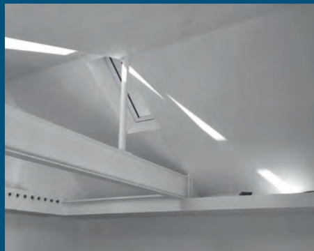
Aus dem Pelz geschält Umbau einer Dachgeschosswohnung, Darmstadt | Architekt*innen: poolX architektur, Stephan Finkel | Bauherr*innen: privat Foto: poolX, Darmstadt
