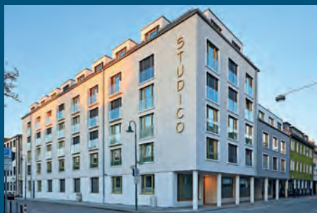
Studentenwohnheim Studico, Darmstadt | Architekt*innen: planquadrat Elfers Geskes Krämer PartG mbB Architekten - Stadtplaner | Bauherr*innen: Krieger + Schramm GmbH & Co. KG Unternehmensgruppe
