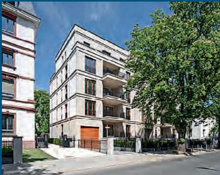
Wohnhäuser Holzhausenstraße, Frankfurt am Main | Architekt*innen: VRL Volleth Russ Lang Architekten GmbH | Bauherr*innen: City 1 Group GmbH
