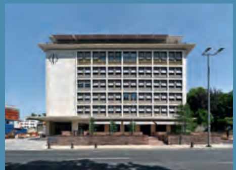
Hessisches Ministerium für Soziales und Integration, Wiesbaden | Architekt*innen: Max Dudler | Bauherr*innen: IFM Property Project Sonnenberger Straße 2/2a GmbH und NORSK Deutschland AG
