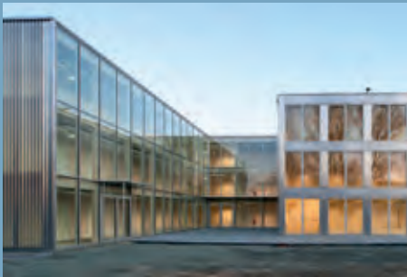
Europäische Schule, Holzmodulbauweise, Frankfurt am Main | Architekt*innen: NKBAK Nicole Kerstin Berganski, Andreas Krawczyk Architekten PartmbB | Bauherr*innen: Stadt Frankfurt am Main, vertreten durch das Amt für Bau und Immobilien Foto: Thomas Mayer, Neuss
